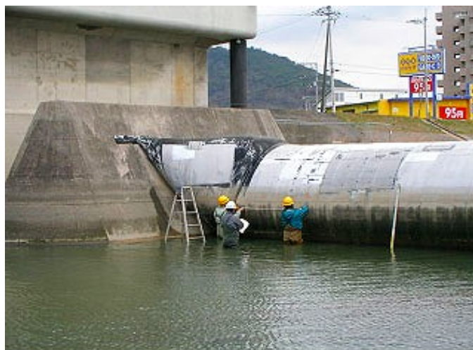
現地調査状況(平成20年1月16日)
