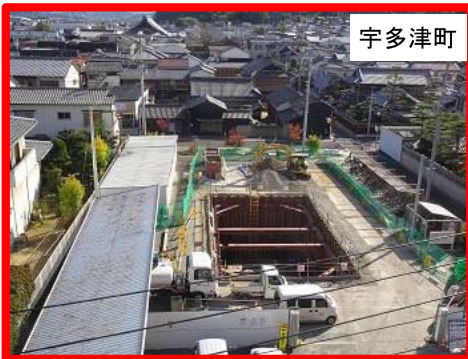
雨水貯留施設整備
