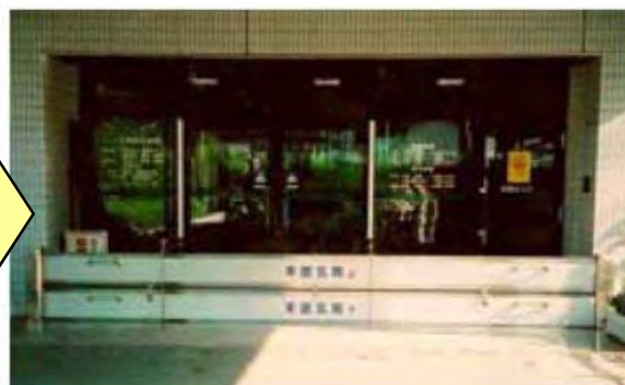
本館玄関への止水板設置状況(設置後)
