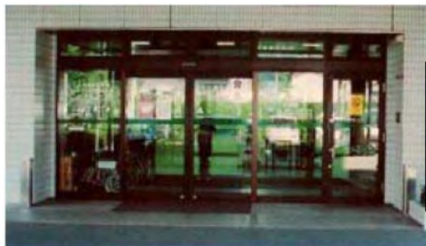
本館玄関への止水板設置状況(設置前)
