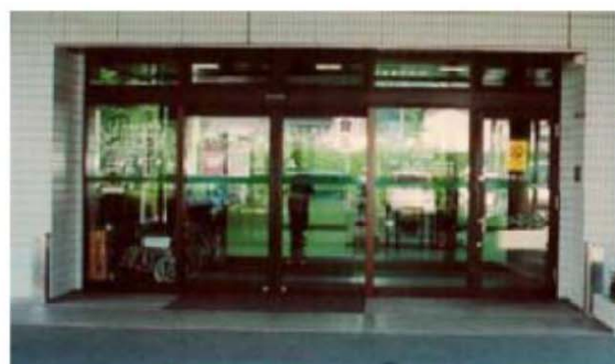
本館玄関への止水板設置状況(設置前) 出典)ヒアリングによる(H21.9.16)
