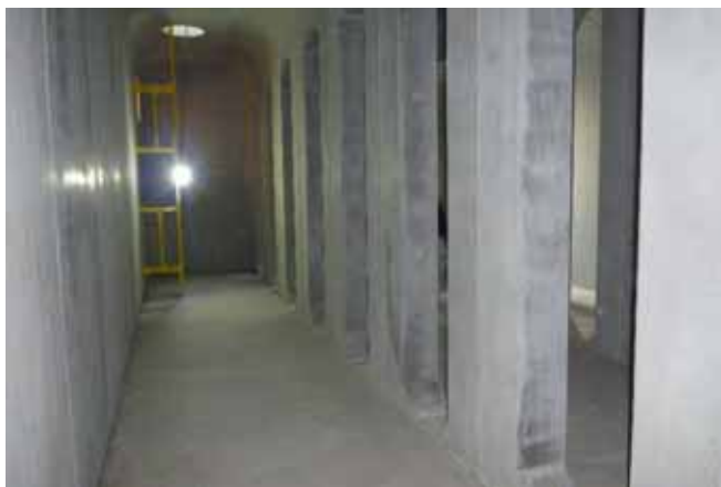
雨水貯留槽の内部状況写真
