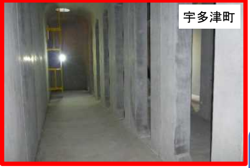
宇多津町 雨水貯留槽の内部状況
