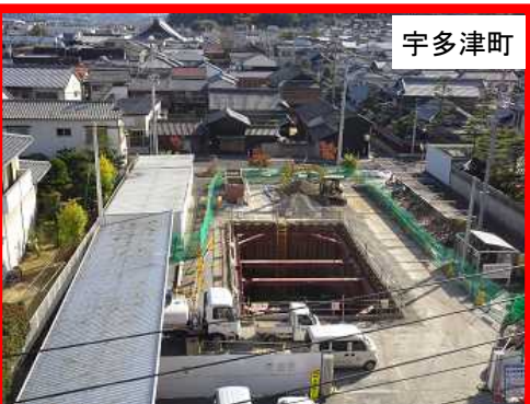
雨水貯留施設整備
