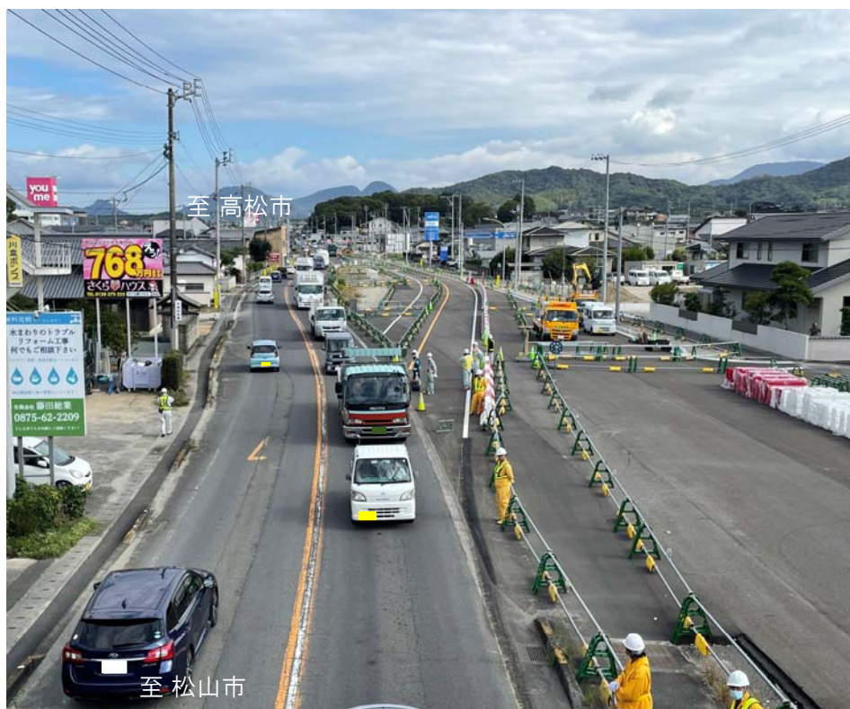
【車線切替え前】
