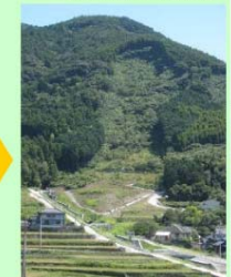
山腹工施工後9年後の様子 (平成30年9月撮影)
