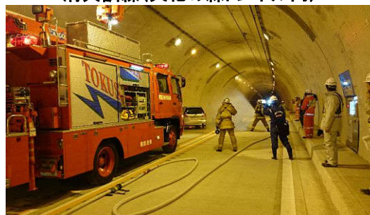
消火訓練(文化の森トンネル内)
