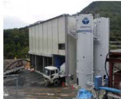
吹付けプラント
