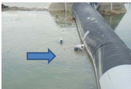
撤去状況写真(バックホウと人力撤去)
