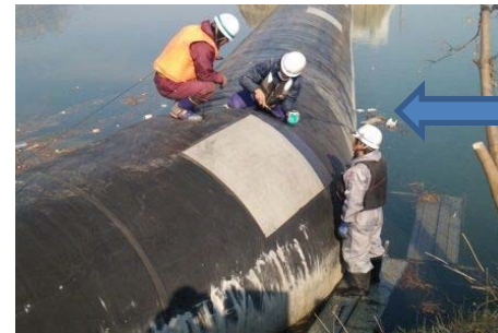
補修状況写真(パッチング補修)
