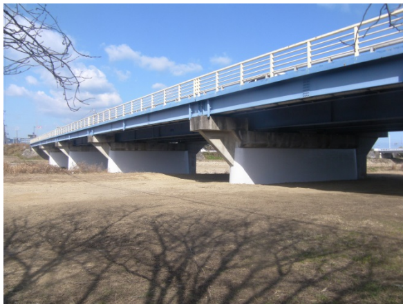
みなとおおはし ◎国道11号湊大橋（東かがわ市湊）
