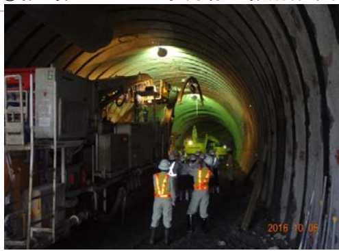
③猪ノ鼻トンネル工事現場 掘削作業状況
