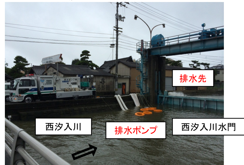
高潮被害防止のため西汐入川水門を閉塞し西汐入川の河川水を海側に排水中
