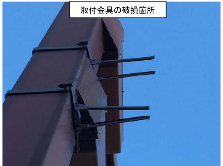
取付金具の破損箇所
