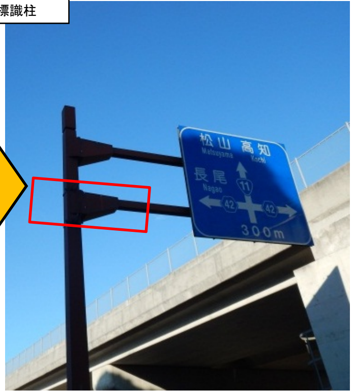
取付金具の破損箇所
