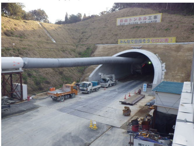
【前山トンネル高松側】
