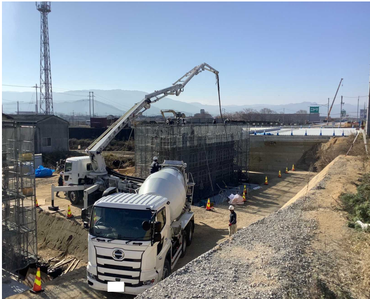
本山甲地区の改良工事を行っています。
