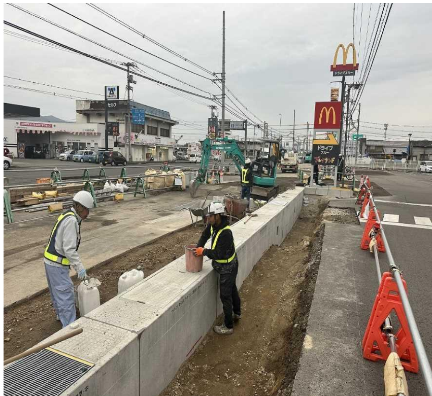
本大地区の改良工事 (排水構造工事) を行っています。
