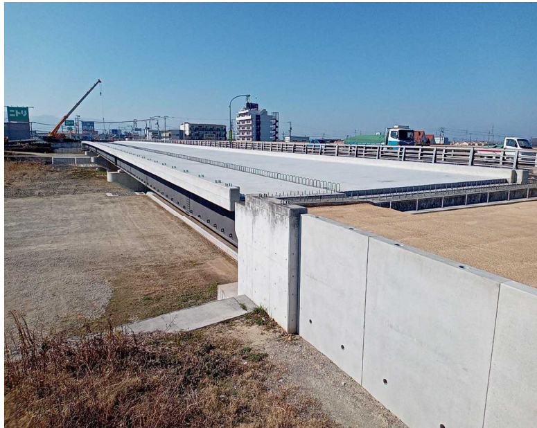
本山橋の床版工事が完成しました。
