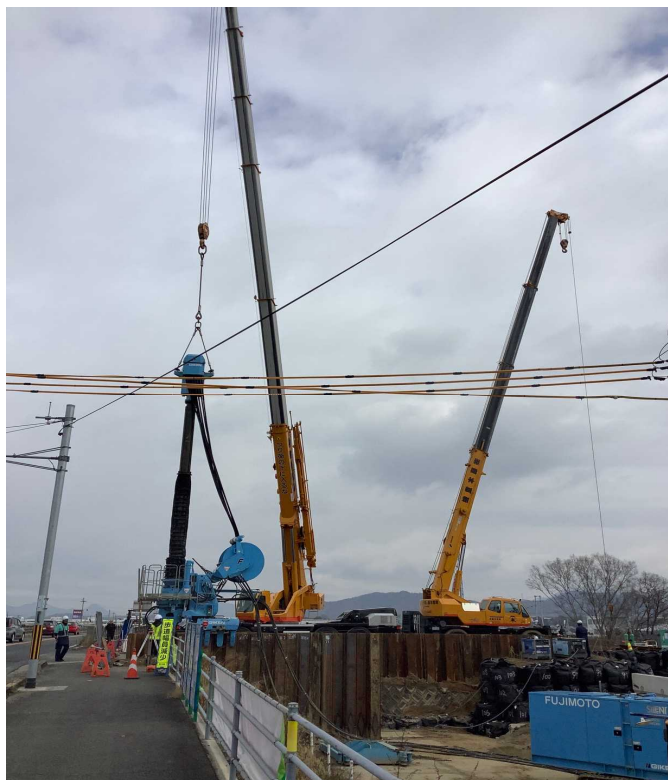
本大地区の改良工事を行っています。
