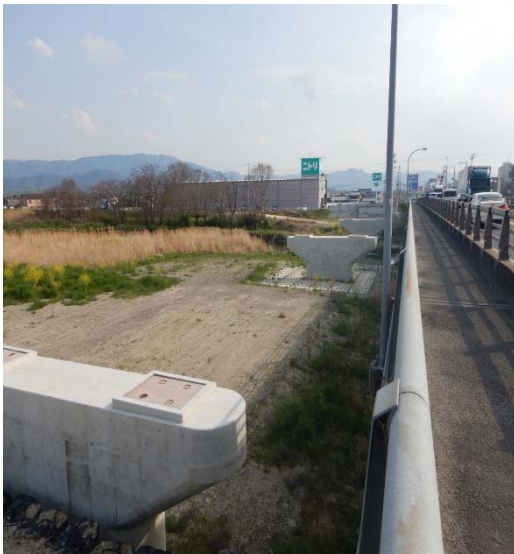
本山橋の下部が完成しました。
