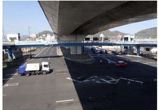
上天神横断歩道橋用エレベーター現地状況(4基)
