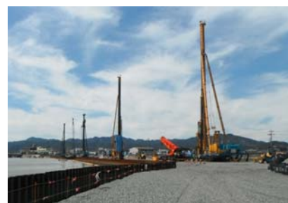
周辺施工状況(サンドコンパクションパイル工法)
