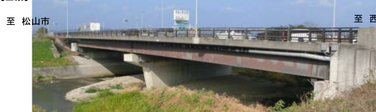
▲頓田川橋 全景
