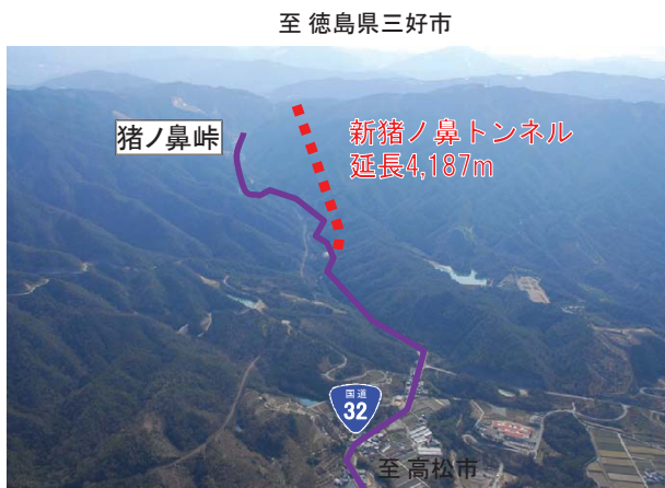
新猪ノ鼻トンネルの工事着手
