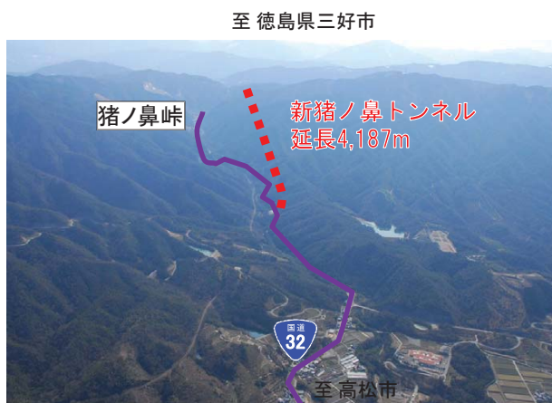
新猪ノ鼻トンネルの工事着手
