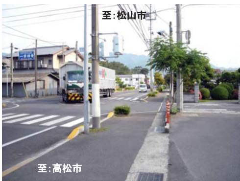
左折時に大型車両が対向車線にはみ出している
