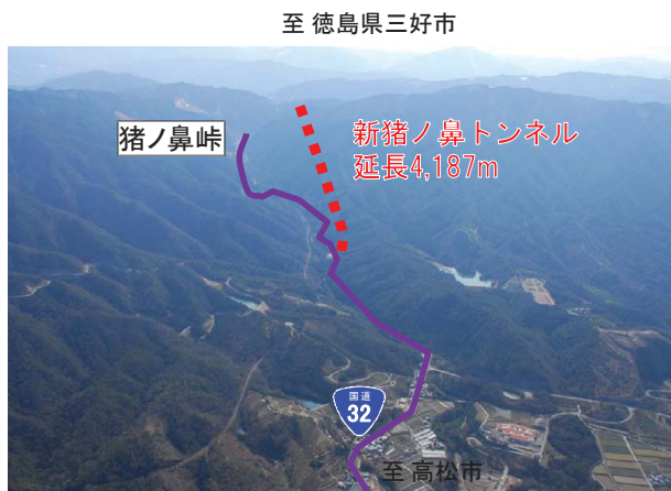
新猪ノ鼻トンネルの工事着手
