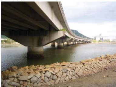
▲屋島大橋 (完成後32年経過)
