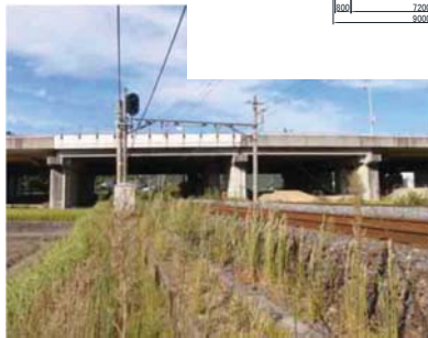
▲府中高架橋 (完成後39年経過)
