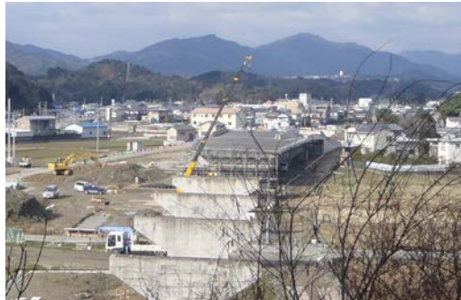
工事が進む日比宇高架橋 (徳島市上八万町広田付近)
