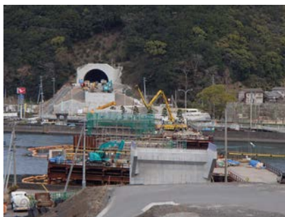
工事が進む近家地区 (宇和島市津島町近家付近)
