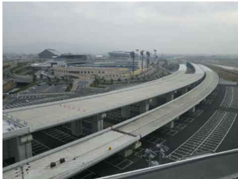
工事が進む松山中央公園高架橋 (松山市市坪西町付近)
