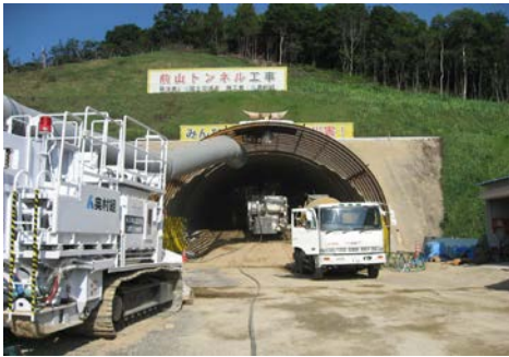
工事が進む前山トンネル ( ひがし 東かがわ市川東付近)
