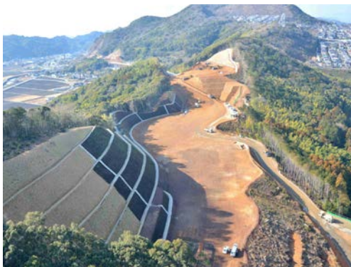
工事が進む高知東 IC 付近 (南国市伊達野付近)
