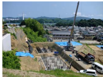
工事の進む阿南道路 (阿南市橋町大浦付近)
