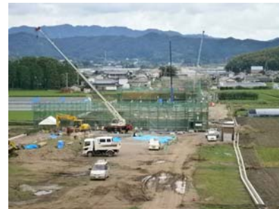
工事の進む南国安芸道路 (香南市野市町東野付近)
