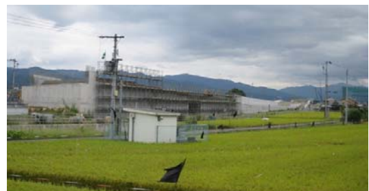
工事の進む まつやまとかんじょう 松山外環状道路 ( ふるかわ 古川IC (仮称) 付近)
