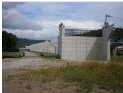
工事の進む南国安芸道路 (香南市野市町土居付近)
