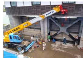
鉄骨プレス設置状況
