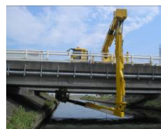
点検車による定期点検
