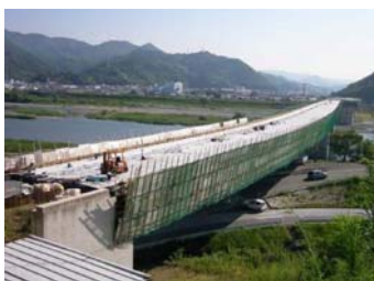
工事の進む高知西バイパス 吾川郡いの町大内付近
