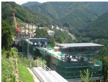
工事の進む三坂道路 (愛媛県松山市つづら川付近)
