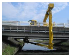
点検車による定期点検
