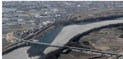
工事の進む土佐市バイパス
