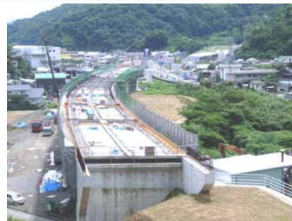
工事の進む四国横断自動車道 (愛媛県宇和島市高串付近)
