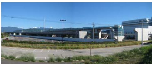
工事の進む松山外環状道路インター線 （松山中央公園高架橋）
