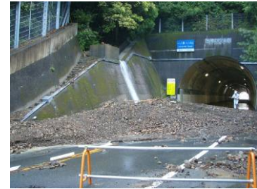
平成 22.4.27 低気圧に伴う大雨による 法面崩壊状況（徳島県美波町）
