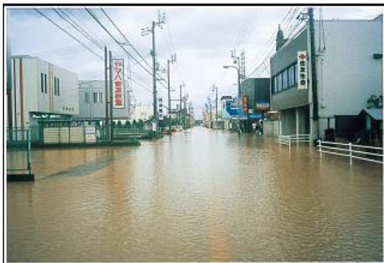
阿南市内の冠水状況 (国道55号阿南市富岡町付近)
