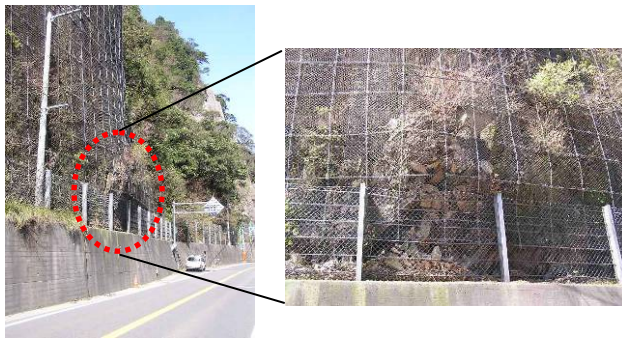
突然の岩盤落下を事前対策にて防いだ事例
