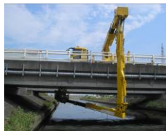
点検車による定期点検
