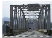
国道33号 仁淀川橋（高知県） 架設後80年経過
