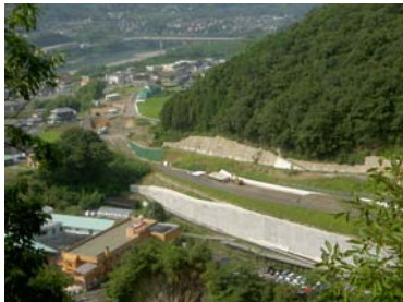
工事の進む猪ノ鼻道路 (三好市池田町州津付近)
