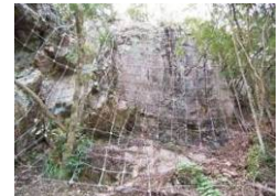
ロープネットによる対策の例
