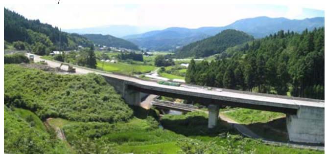
工事の進む三坂道路 (愛媛県上浮穴郡久万高原町東明神付近)
