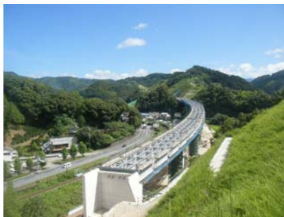
工事の進む四国横断自動車道 （愛媛県宇和島市家藤付近）
