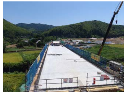
工事の進む日和佐道路 (徳島県阿南市福井町小野付近)
