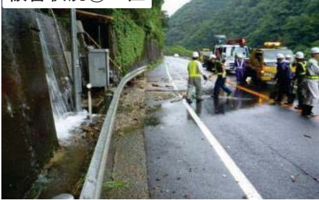
被害状況①工区
