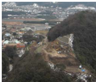
工事の進む猪ノ鼻道路 (三好市池田町付近)
