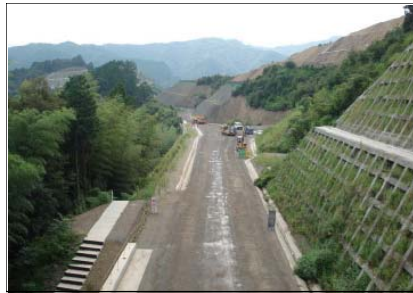
工事の進む四国横断自動車道 (高岡郡中土佐町和田地区)
