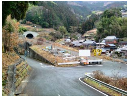
工事の進む地芳道路 (高知県高岡郡檮原町永野地区)
