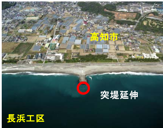
高知海岸長浜工区における突堤延伸
