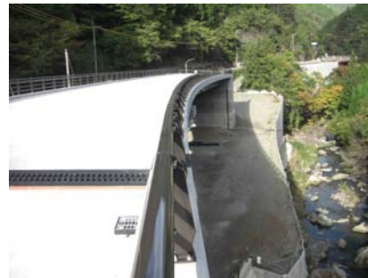
工事の進む地芳道路 (愛媛県上浮穴郡久万高原町西谷地区)
