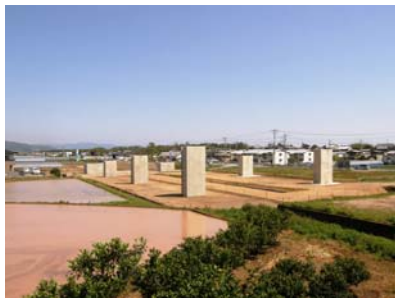
工事の進む南国安芸道路 (高知県安芸郡芸西村西分地区)
