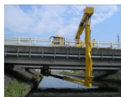
点検車による定期点検
