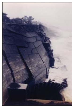
長浜工区H3 被災状況
