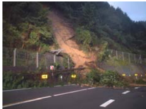
平成16年台風21号による法面崩壊状況 (松山市久谷町つら川付近)
