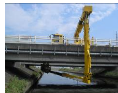
点検車による定期点検
