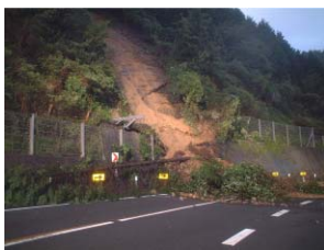
平成16年台風21号による 法面崩壊状況 (松山市久谷町つづら川付近)
