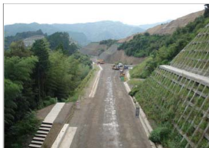
工事の進む四国横断自動車道 たかおか なかとさちようわだ (高岡郡中土佐町和田地区)
