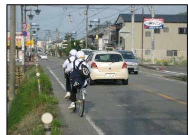
歩道未整備状況
