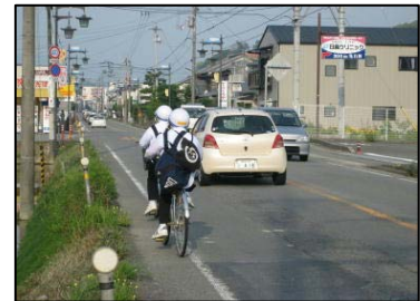
歩道未整備状況
