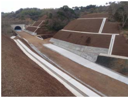
工事の進む南国安芸道路 (高知県安芸郡芸西西村西分地区)
