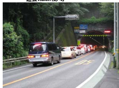
須崎市内の渋滞状況 やけざか (国道 56 号焼坂トンネル終点)
