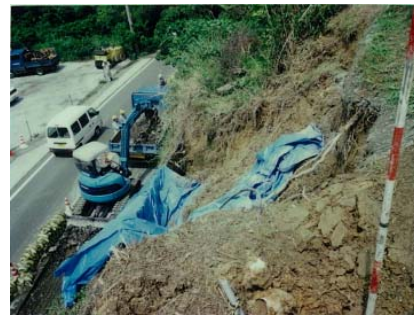
工事の進む南国安芸道路 (高知県香南市夜須町手結山地区)
