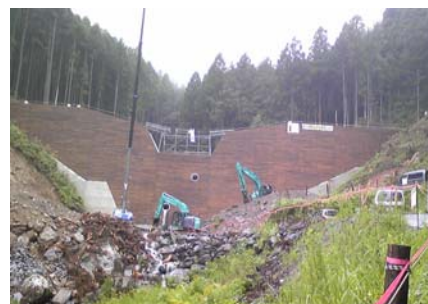
吉野川水系砂防事業(屋所谷砂防えん堤) (高知県本山町)
