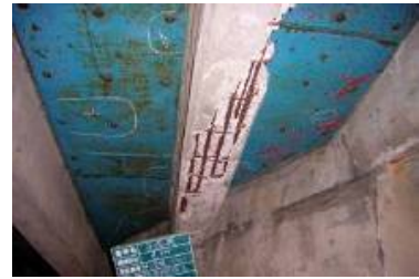
高齢化が進む道路橋
