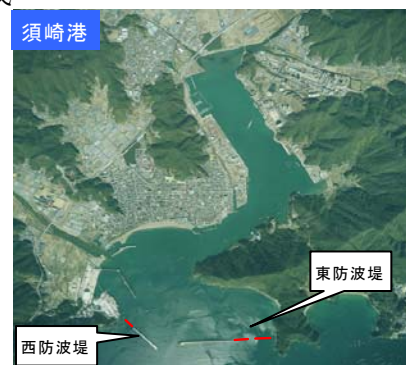
須崎港湾口地区津波防波堤の整備 (高知県須崎市)
