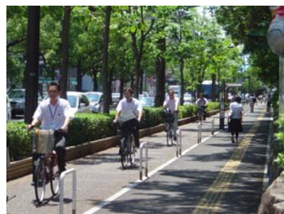
自転車歩行者道路の整備 (国道11号高松市中央通り/整備後)
