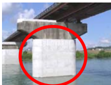
鉄筋コンクリート巻き立てによる 対策例
