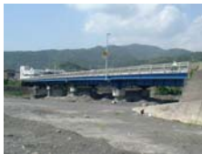
国道55号羽根川橋 (高知県)
