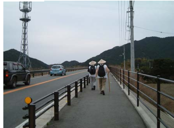
歩道拡幅後 W=2.5m (整備後)
