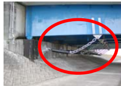
落橋防止による対策例
