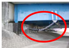
落橋防止による対策例
