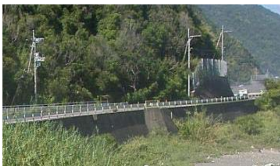
歩道設置（整備前）
