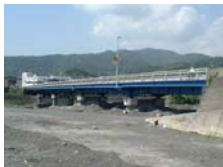
国道55号羽根川橋 (高知県)
