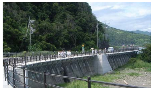
歩道設置（整備後）
