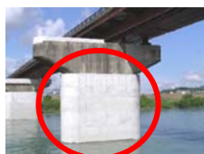
鉄筋コンクリート巻き立てによる 対策例
