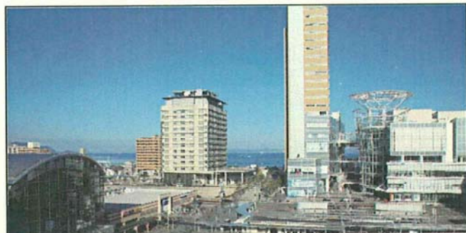
高松駅前広場より高松サンポート合同庁舎を望む(現庁舎手前側にB棟を建設予定)
