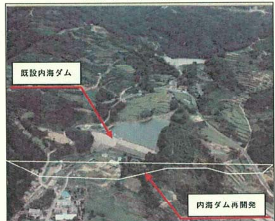
ダムサイト状況
