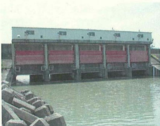
【仁淀川／新居樋門】
