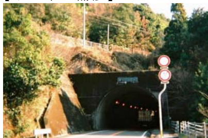
国道55号古江トンネル
