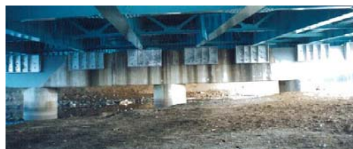
旧道路橋示方書適用(S39)の橋脚
