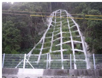
法枠工による対策例
