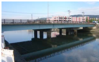
国道11号新詰田川橋(香川県)
