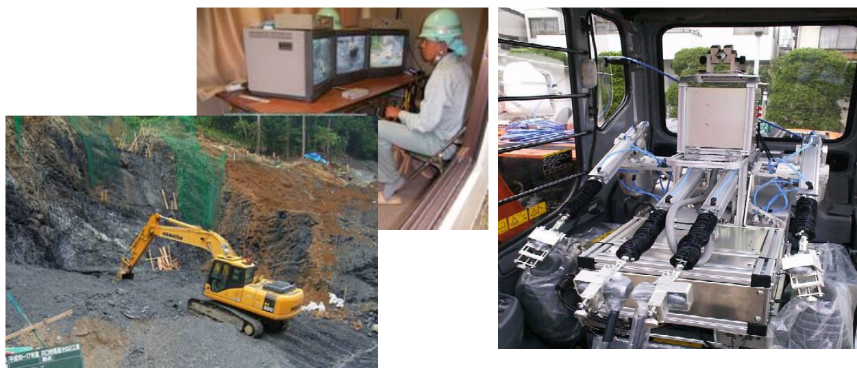
災害対策として有用である建設機械遠隔操縦技術の活用促進
