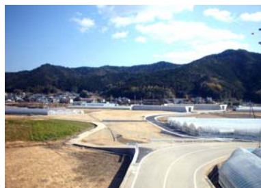
南国安芸道路 夜須IC周辺の状況
