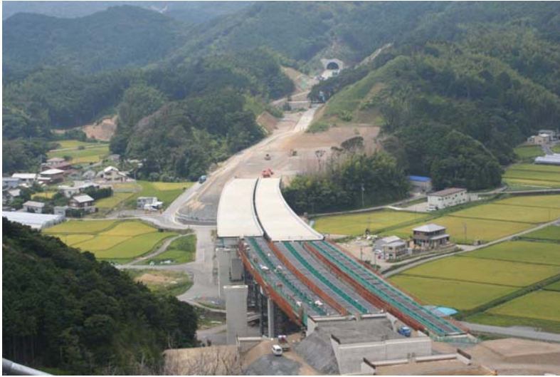
【四国8の字ネットワークを構成し、早期供用に向け整備の進む 国道55号日和佐道路(由岐IC上空から木岐第1トンネル坑口を 望む(高知方面))】
