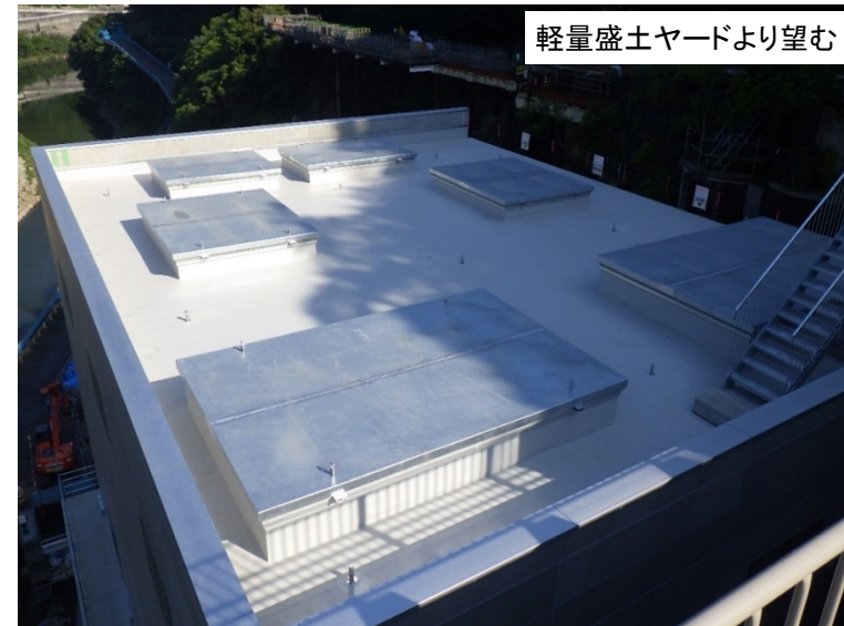
5月31日 完成(吐口建屋棟)
