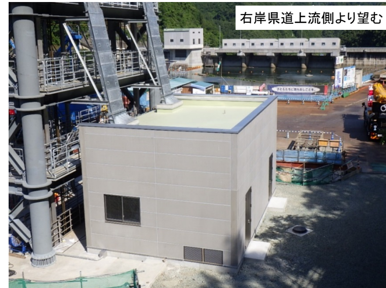
5月31日 完成(呑口建屋棟)
