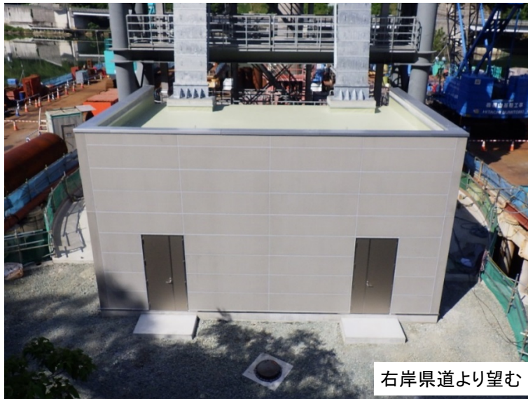
5月31日 完成(呑口建屋棟)
