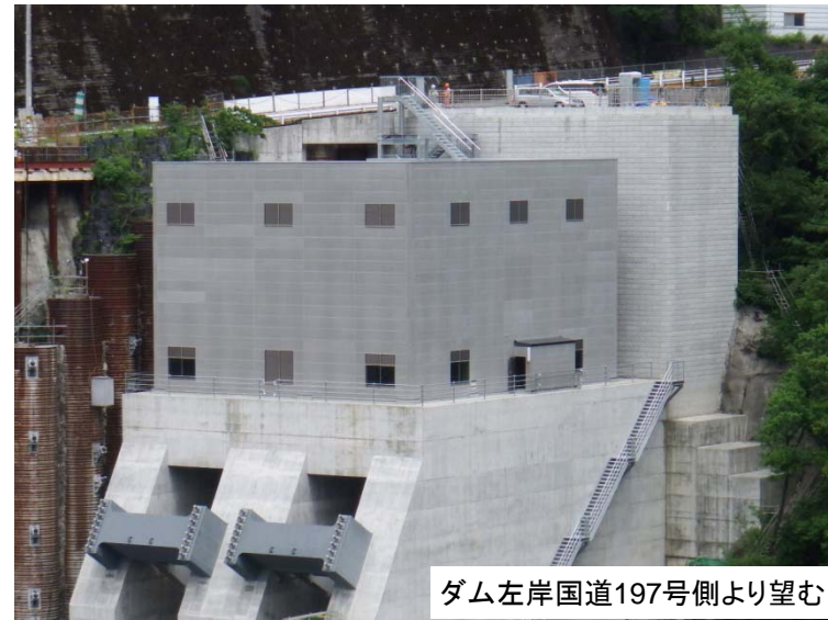
5月31日 完成(吐口建屋棟)
