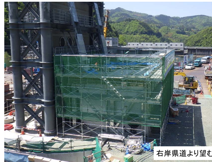
4月23日 呑口建屋棟全景
