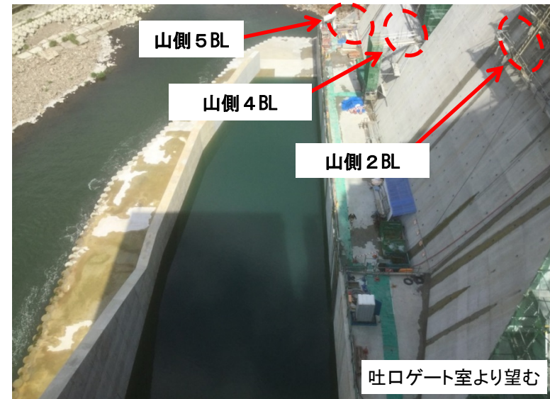
4月29日 山側2BL・4BLレイタンス処理、5BL型枠組立
