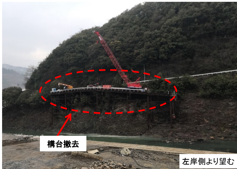
4月1日 工事用進入部構台撤去
