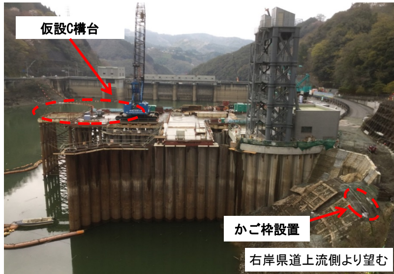
4月1日 呑口仮設(A・C)構台撤去、かご枠設置
