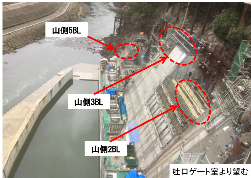
3月18日 山側2BL鉄筋組立、3BL・5BL型枠組立
