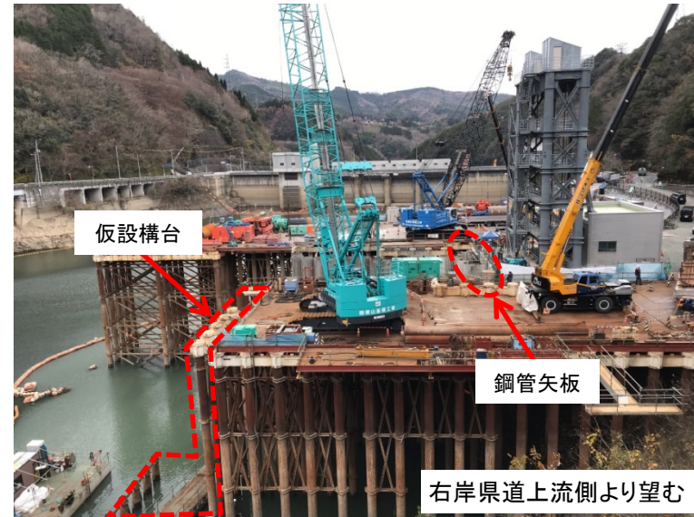
12月10日 呑口鋼管矢板切断、仮設構台解体
